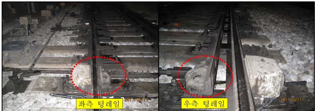
[그림 13] 제0458호 선로전환기 좌·우 텡레일 손상 상태
