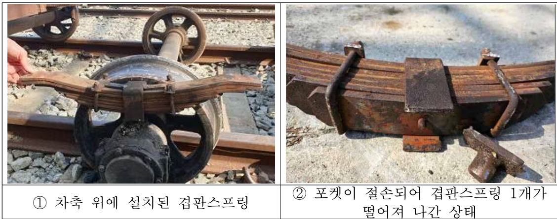
[그림16] 차축 위에 설치된 곱판스프링 및 절손된 포켓
