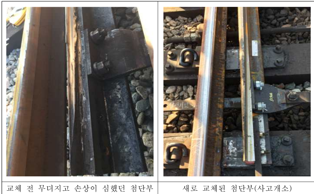
[그림9] 429B호 선로전환장치의 텅레일 교체 전과 후의 모습
