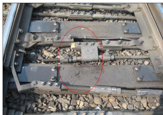
그림 5. 55호 선로전환기 파손
