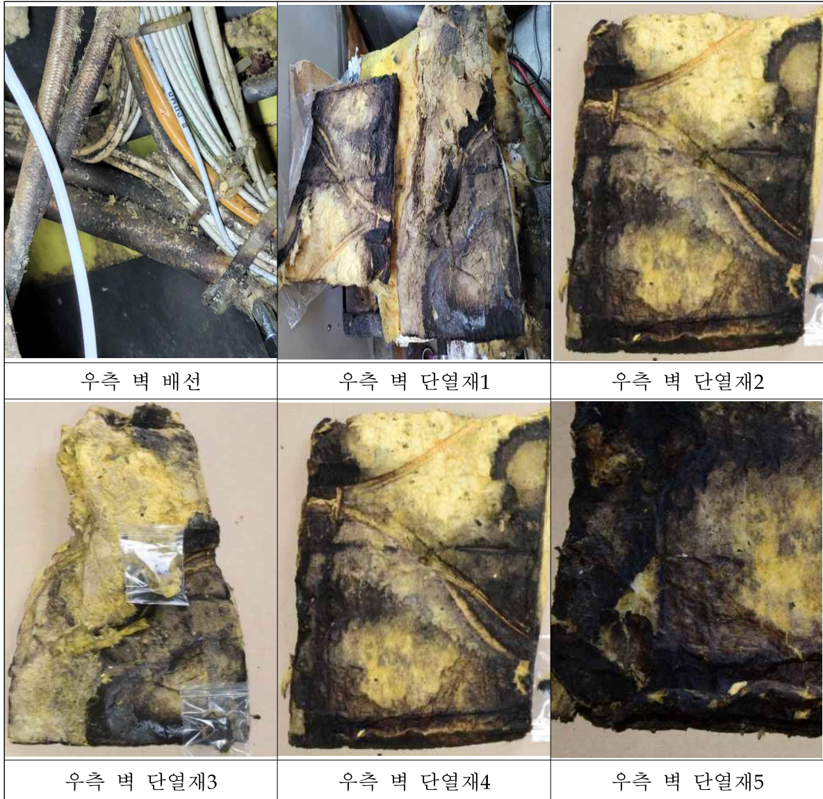
[그림 7] 기체 단열재 상태
