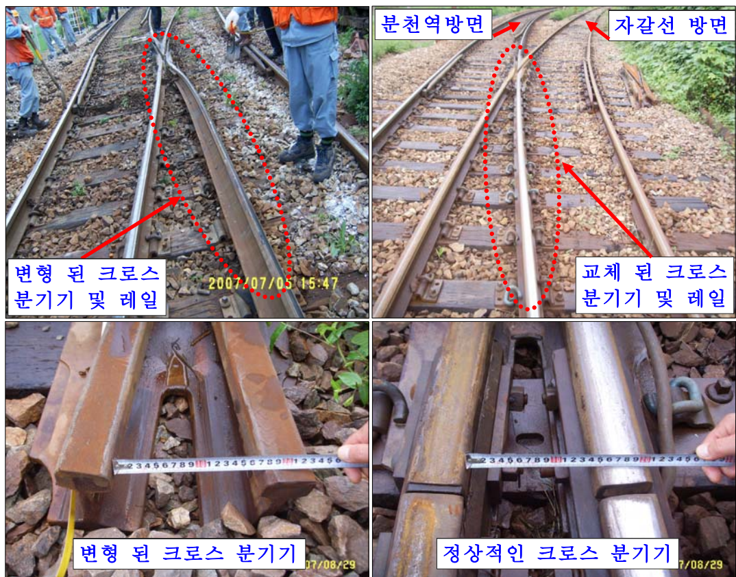
그림 11. 크로싱 분기기 상태
