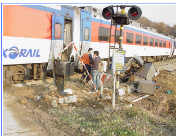
그림5. 열차충돌로 차단기 파손
